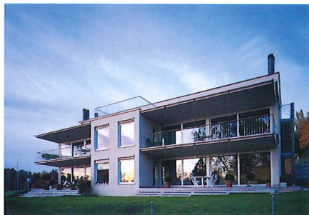
Abb. oben: Grosszügige Verglasungen auf der Südseite öffnen den Blick auf den See und die Berge.
