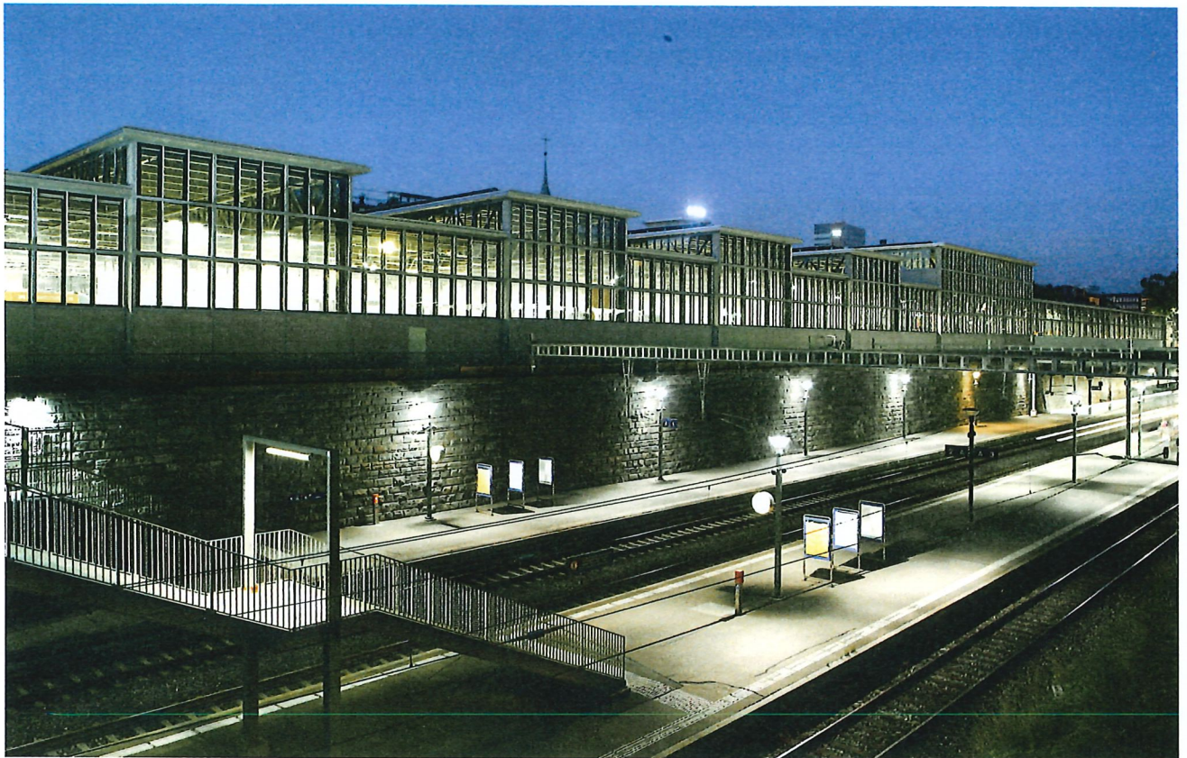
Die sanierte Südwestfassade des Tramdepots an der Kalkbreite.
